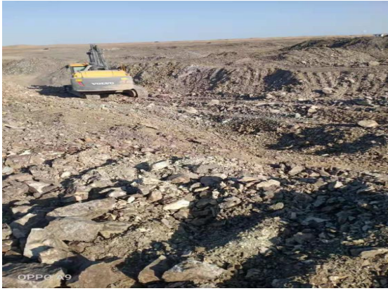
照片 2-5 原露天采坑剥挖场地
