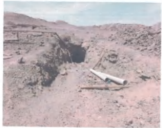
照片 1-24 斜井工业场地
