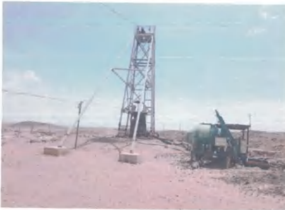
照片 1-23 竖井工业场地
